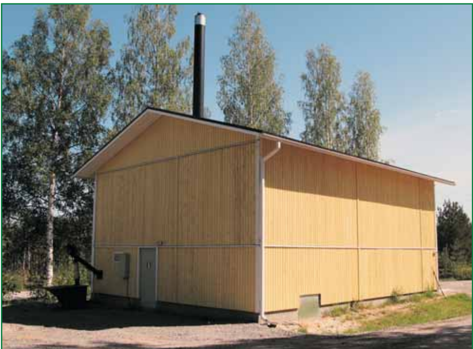
250 kW paikalle rakennettu lämpökeskus. Yläkuvassa rakennus perustusvaiheessa.
